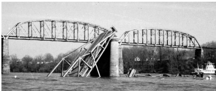
Kolaps oceľového mosta v USA vo Virgínii v roku 1967 [1]
