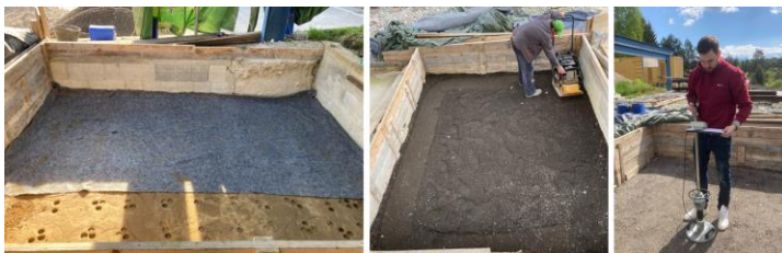
Obr.6 Aplikovanie vrstvy R-materiálu s následným hutnením a meraním únosnosti
