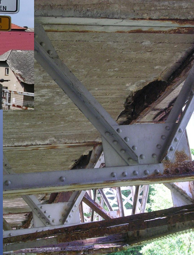
Totální destrukce mostu při absenci odvodnění
