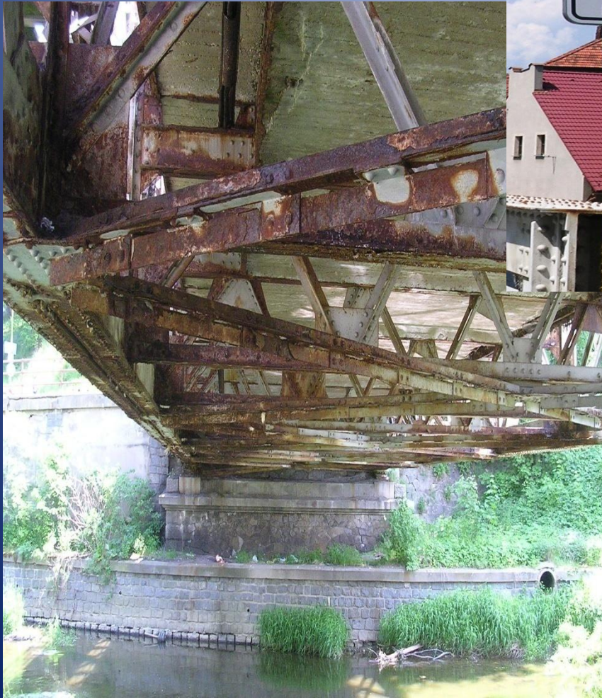
Totální destrukce mostu při absenci odvodnění
