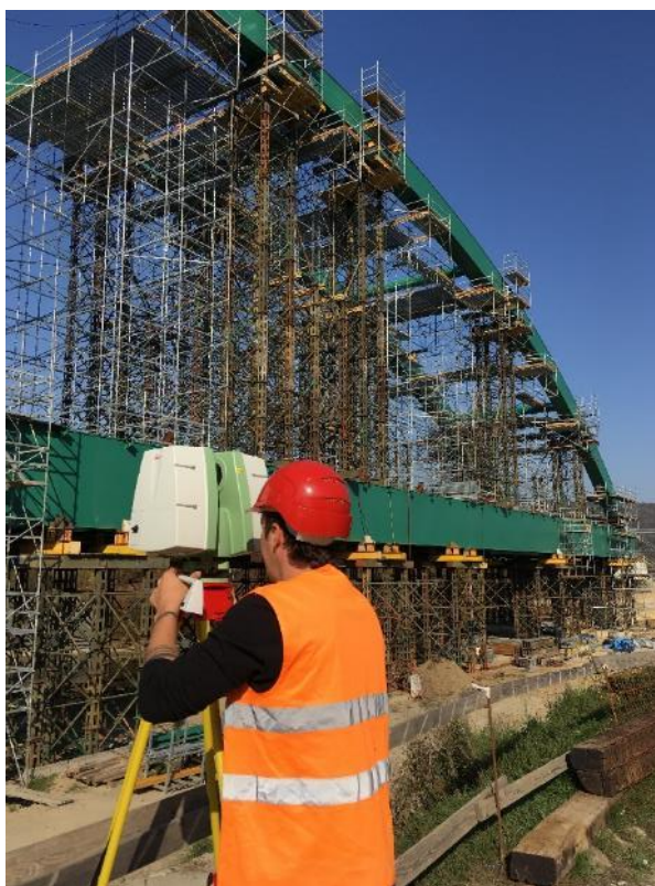
Obr. 15. Bezkontaktné terestrické laserové skenovanie a meranie deformácií inžinierskych konštrukcií
